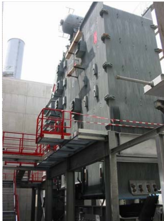
Kessel nach dem Einheben auf dem Kesseltisch
