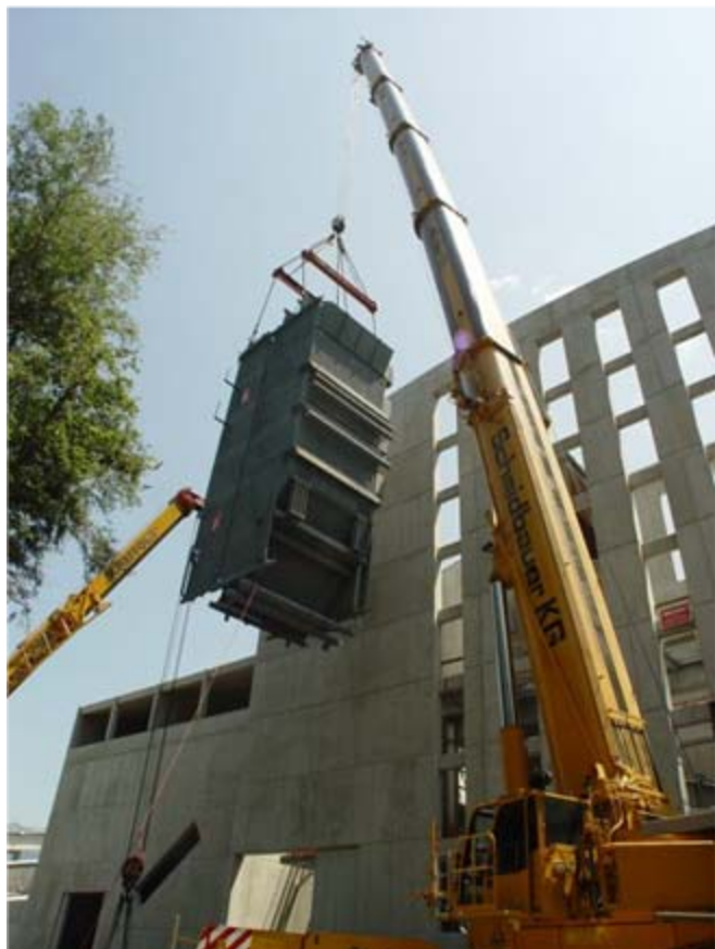
Einheben des Kessels mit 400 to Kran
